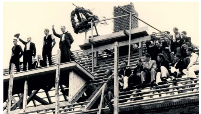
Richtfest am neu erbauten Lehrlingsheim „Ora et labora“ 1954
