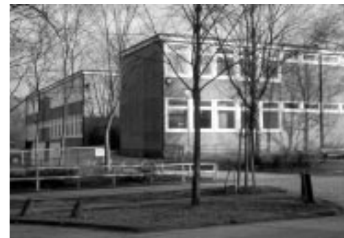
Die neu angemieteten und ausgestatteten Schulpavillons
